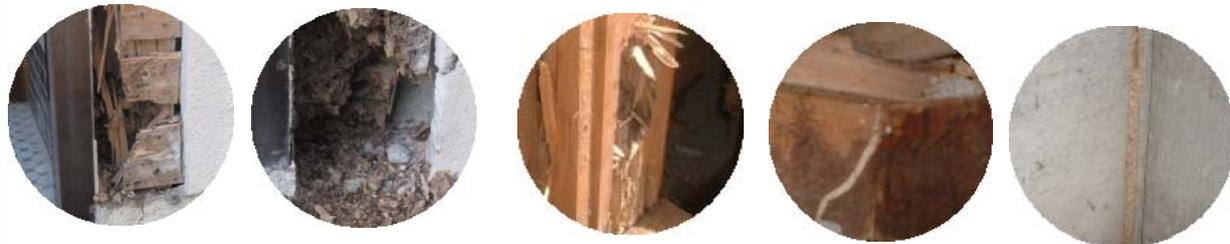
↑ 食害された玄関先の外壁内の木部    ↑ 内部を食害された柱    ↑ 床下の蟻道（アリの通り道）
